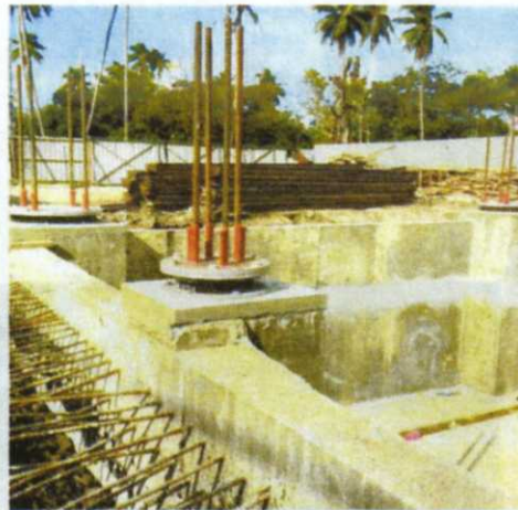
GALAS getah seismik dipasang di sebuah bangunan milik Lembaga Getah Malaysia di Langkawi.
